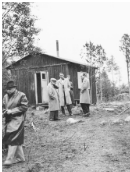
Tidig bild från byn. Planering av byggnation. Mannen i fluga är Lars Lindholm. T h står Olle Rydner. Mannen i regnkappan är förening- ens förste sekreterare.
