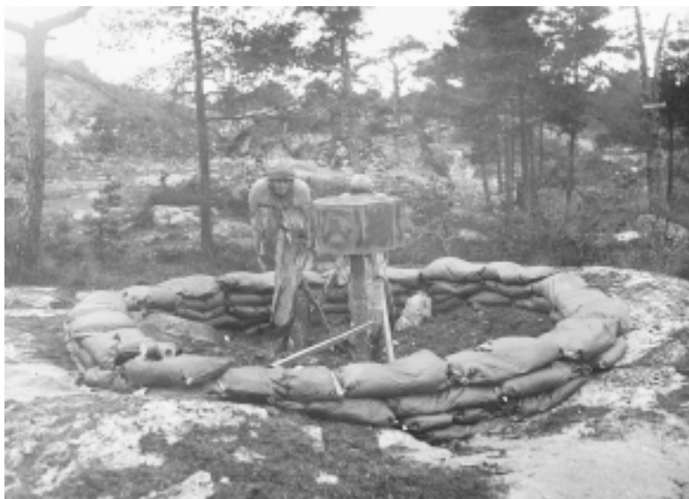
För att förvill fienden anlades skenanläggningar på andra platser än de där vi hade våra luftvärnsställningar. Detta är skenanläggning för batteriplats.
