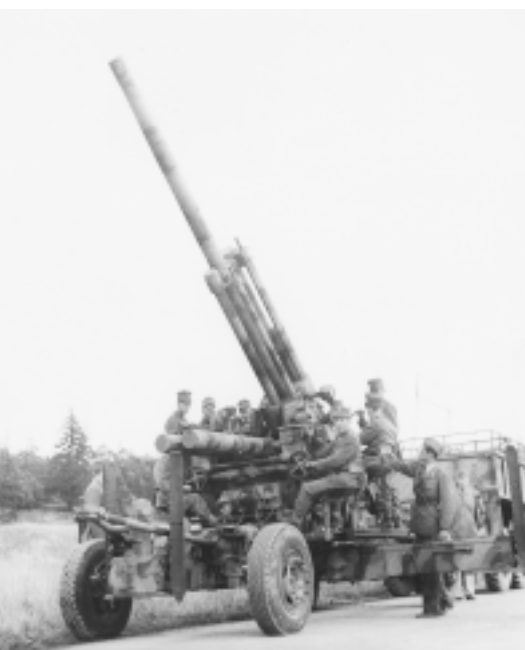
1943 kom 10,5 cm lvkanon m/42. Största skottvidd 16 000 m, största höjd 11950 m. Sista grundutbildning 1959 – 60, då med centralsikte och -instrument m/50.
